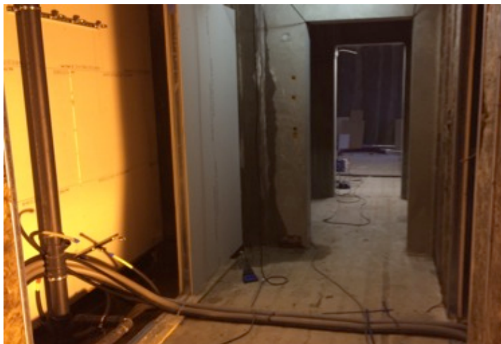
Billede af byggeplads fra det antropologiske feltarbejde.
