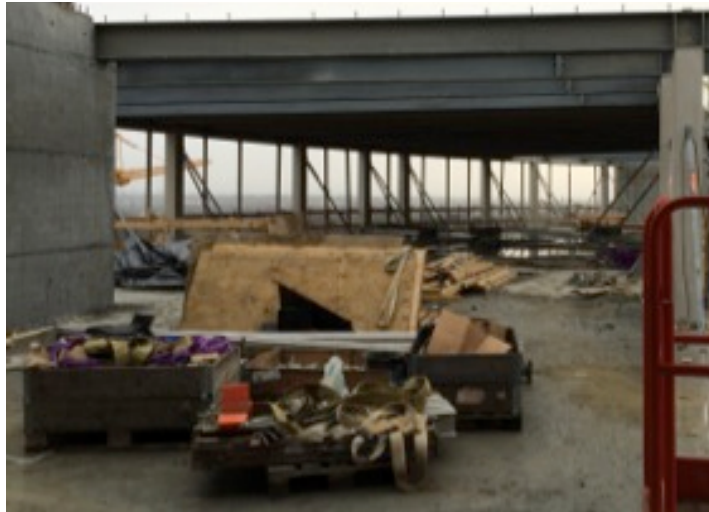
Billede af byggeplads fra det antropologiske feltarbejde.
