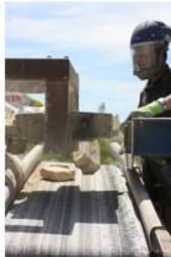
Rensning af mursten Gamle Mursten, Hedehusene
