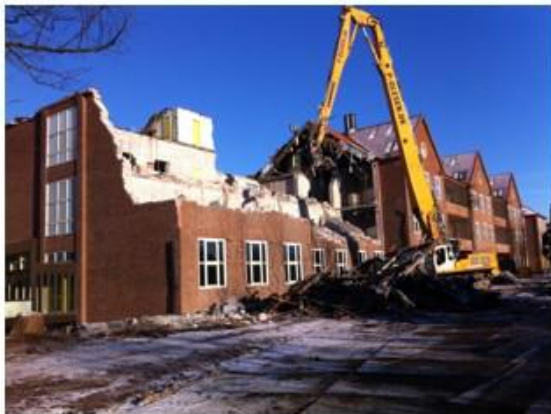
Nedrivning af bygning 13, Bispebjerg Hospital
